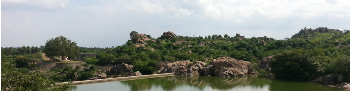
Wasserentnahmestelle für die Trinkwasserversorgung der Stadt Tiruvannamalai am Fluss Then-Pennaiyar (Quelle: IEEM).
