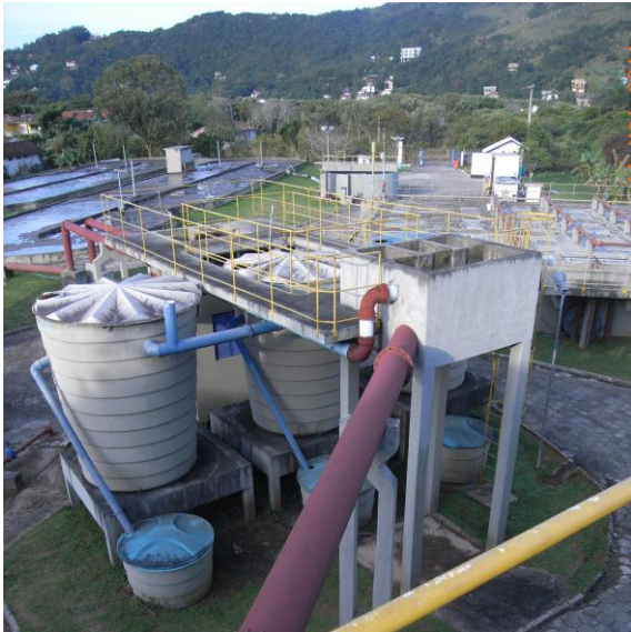
Kläranlage Lagoa de Conceicao mit UASB Reaktor und Besuch des geplanten Versuchsstandorts der Universität in Rio de Janeiro (Prof. Isaac Volschan Jr., UFRJ) (Foto AKUT)
