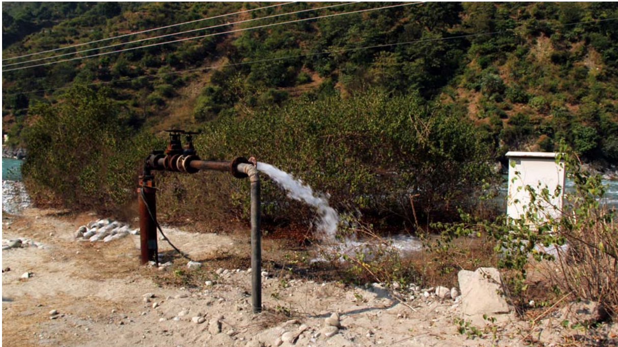
Brunnen am Uferfiltrationsstandort Karnaprayag am Fluss Alaknanda in Uttarakhand, Nordindien (Foto: L. Rossoff, 2011, HTW Dresden)
